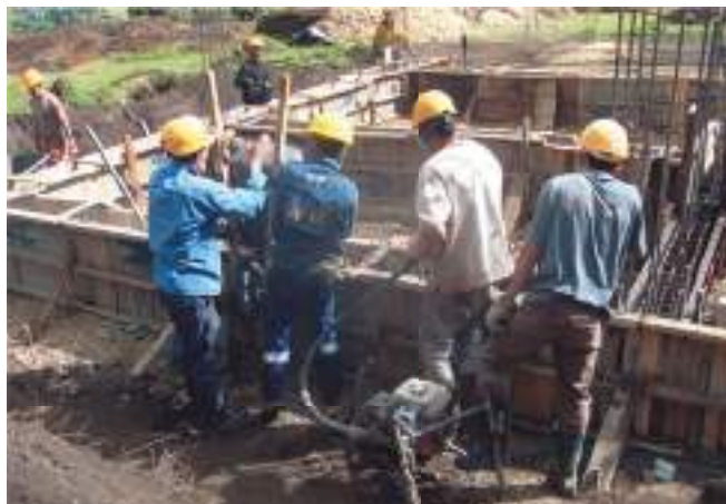
Fundición de las vigas.
