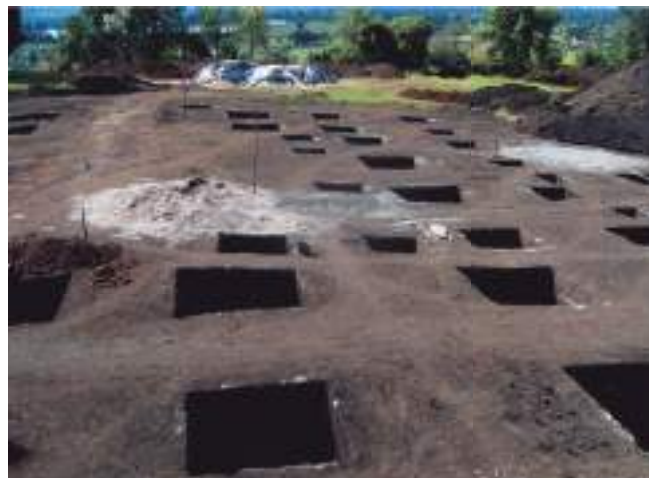
Excavaciones para construir las zapatas de 2 metros de profundidad.
