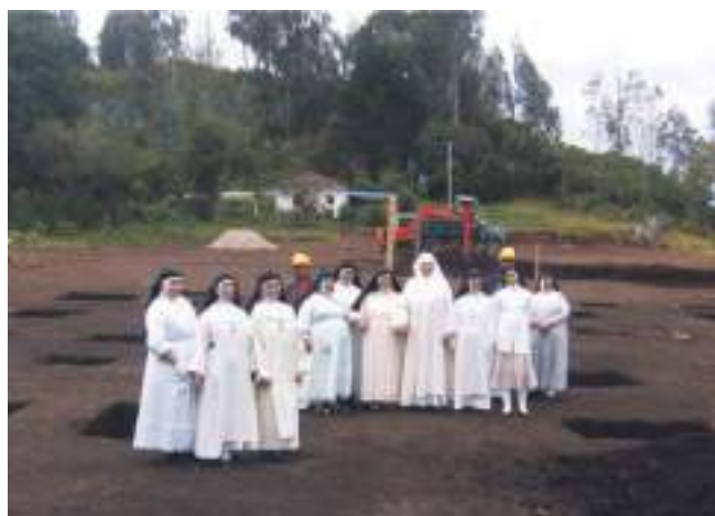
Las monjas recorriendo el terreno de la futura construcción
