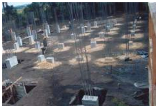
La fundición de las zapatas y el levantamiento de las columnas.
