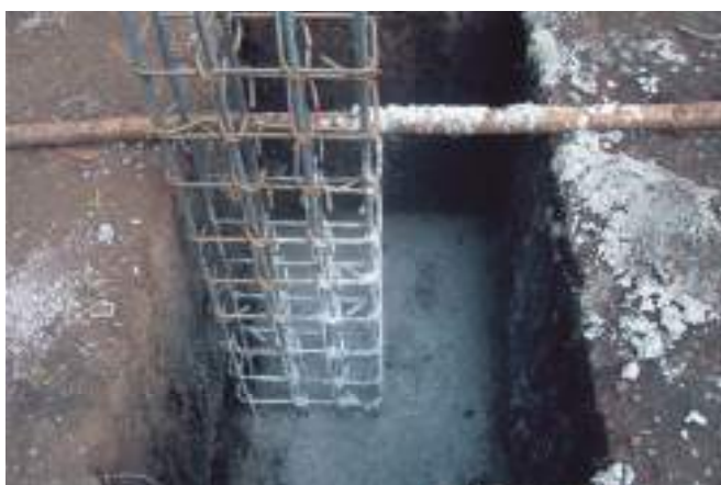
Fundición de las zapatas y columnas.
