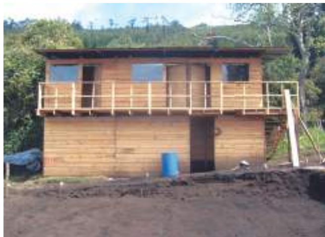
El almacén para la construcción y lugar para las reuniones del comité de obra.
