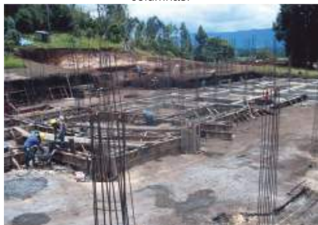
Avances de la obra.
