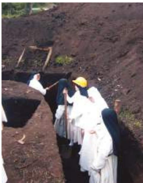
Las monjas dentro de los cimientos del edificio del nuevo monasterio.
