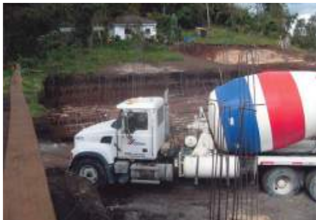
A diario llegan de estos carros mezcladores con el material para la fundición en la obra.
